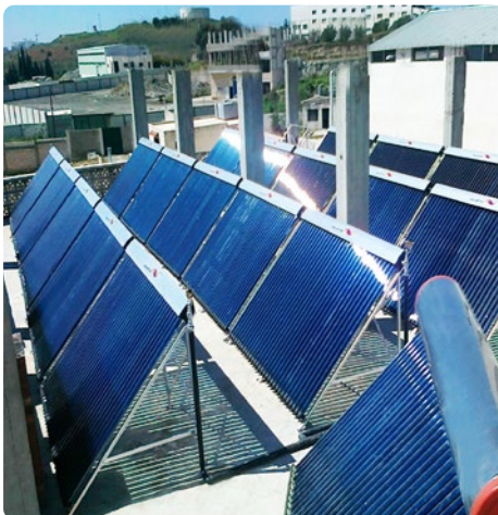
Panneaux chauffants solaires pour toitures d'appartements
