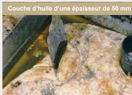
Filtre à graisse
