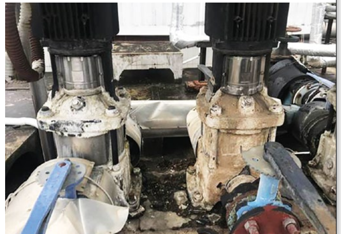
À gauche, le tuyau (débarrassé du calcaire) 2 mois après l'installation de Vulcan S25, à droite, le tuyau non traité.
